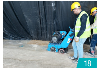
Beton Kazıma ve Kot Düşürme Uygulamaları
